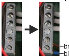
8. Schließen Sie die Verschraubungen der Anschlüsse.
