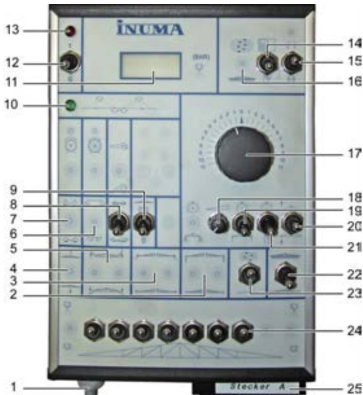
Abb. 32: Elektrischer Schaltkasten im Fahrerhaus
