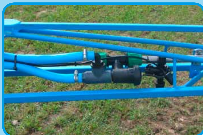
Ringspüleleitung bis zur letzten Teilbreite
